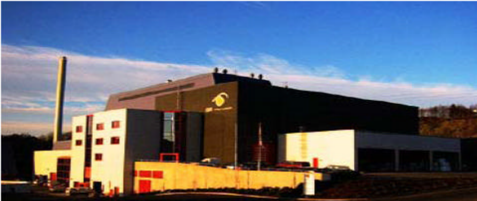
Figur 3: Avfallsforbrenningsanlegget i Bergen og Rådalen Fana Kraftvarmeverk
